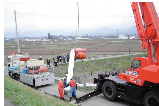
設置作業の様子
