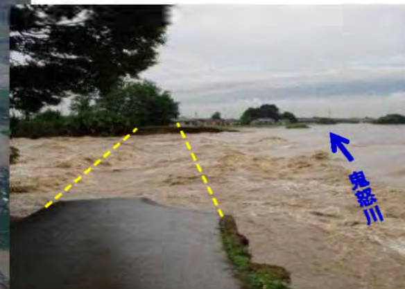
被災状況(拡大写真)
