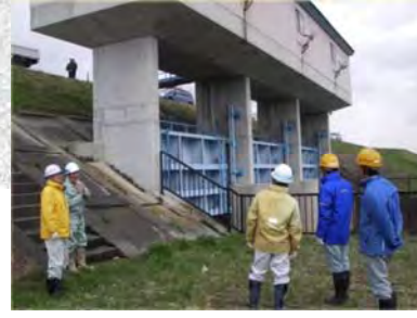
水位観測員との合同点検
