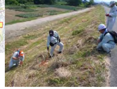
事務所職員による堤防点検
