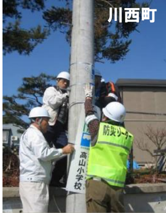
標識の設置状況
