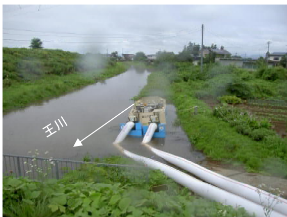
排水ポンプ車による内水排除 （山形市榎沢地区（H25. 7. 18））
