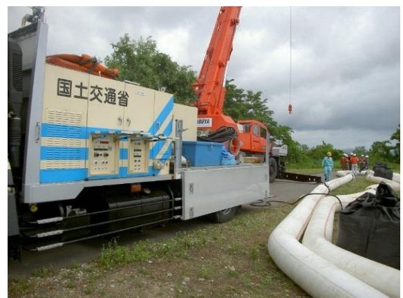
排水ポンプ車設置、排水訓練（平成 27 年）
