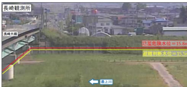
CCTV カメラ基準水位イメージラインの提供
