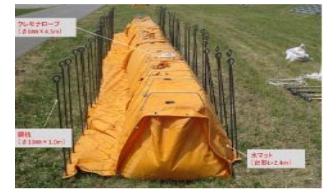
水マット工法
