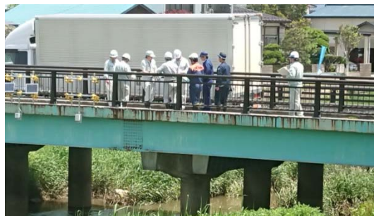
国・県との管理境の高畠町津久茂橋から和田川を点検
