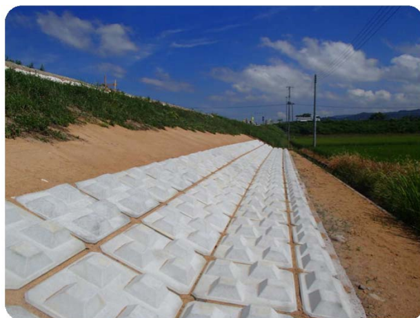
▲ 大型連節ブロック設置完了
