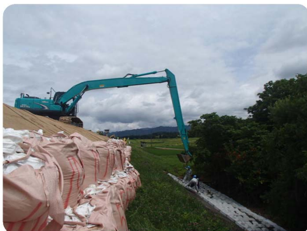
▲ 大型連節ブロック設置状況
