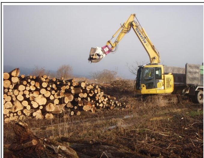
グラップル付BHによる積込作業
