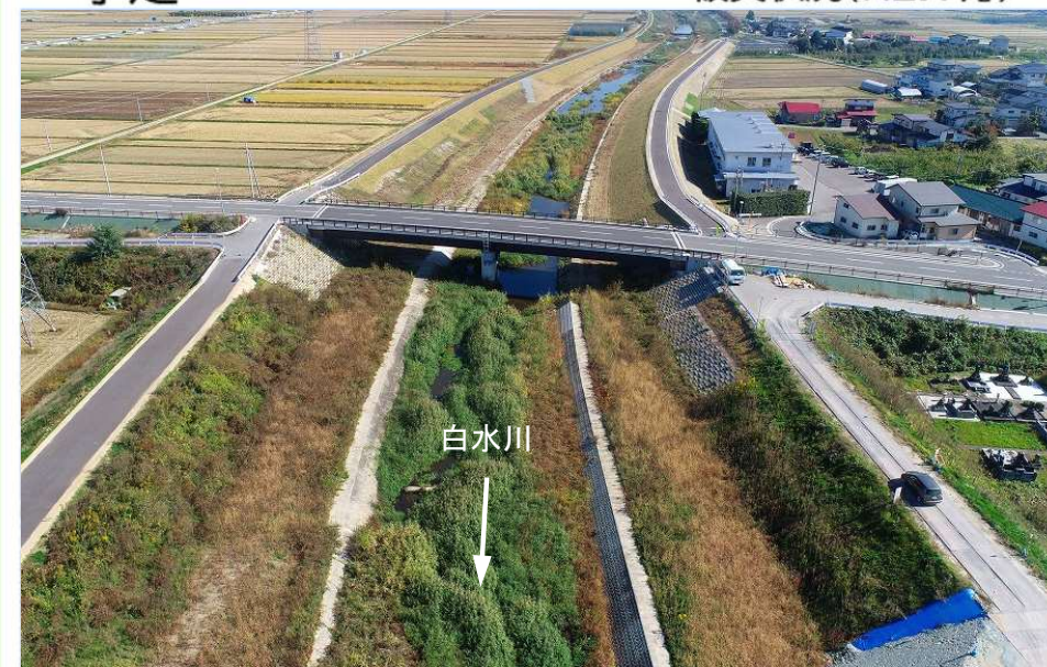
施工状況 (R4.10月)
