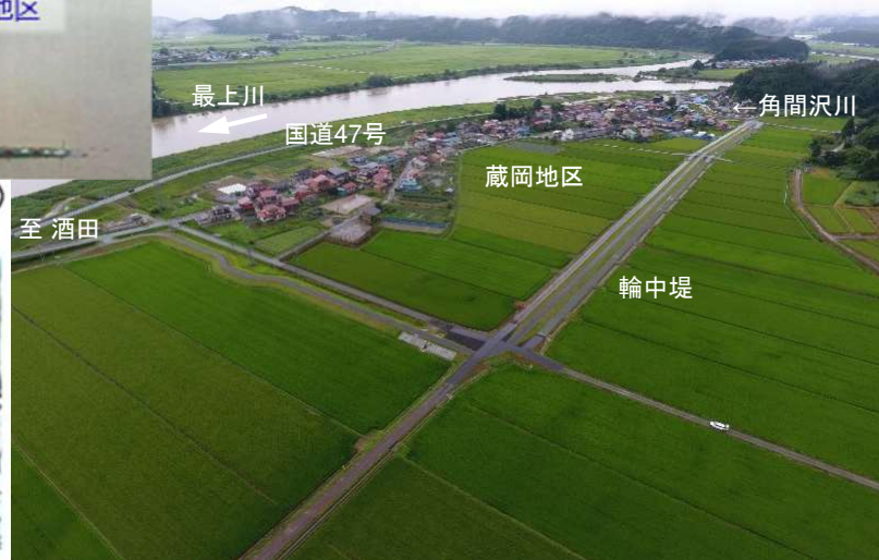
輪中堤整備状況 (R4.7月)
