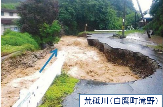
濁流により護岸・道路(約70m)が流出
