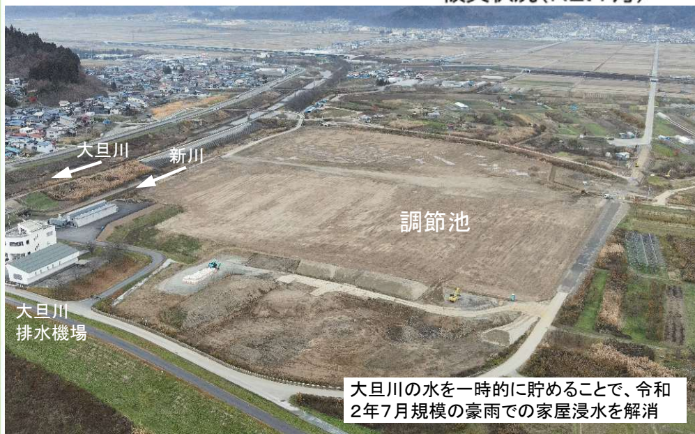
施工状況 (R4.11月)
