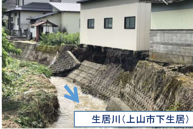
濁流により護岸(約80m)が流出
