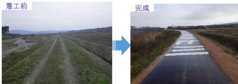
堤防強靱化実施状況(升形川[新庄市])
