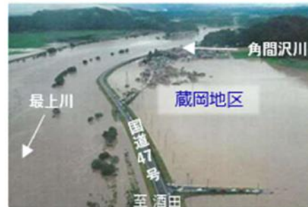
↑被災状況(H30.8月)
