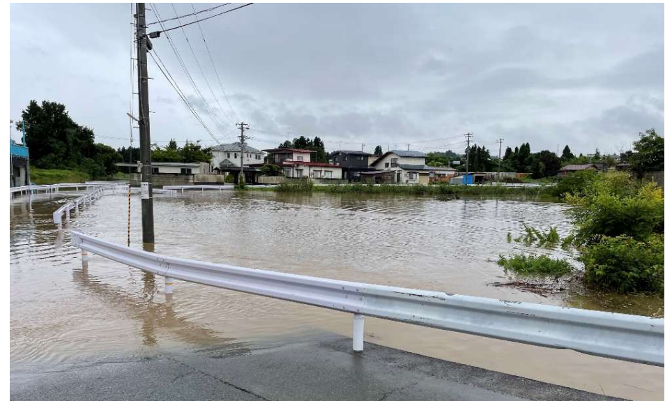
大江町左沢地区における内水被害
