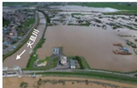
被災状況(R2.7月)
