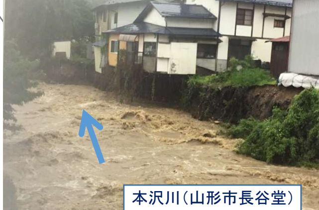
濁流により護岸(約80m)が流出
