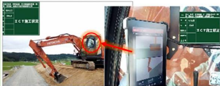
築堤工事で「ICT施工」を実施、工期短縮等により生産性向上
