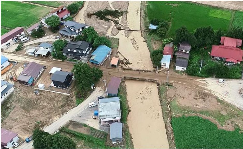
飯豊町萩生地区における浸水被害
