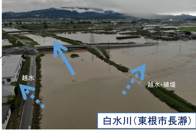
濁流により護岸(約20m)が損壊
