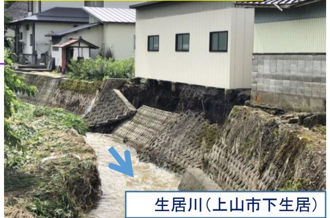
濁流により護岸(約80m)が流出
