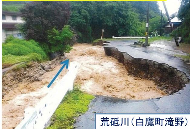
濁流により右岸堤防(約30m)が決壊
