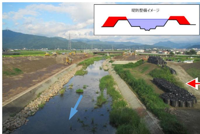
堤防嵩上げ工事の施工状況
