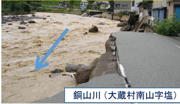
濁流により護岸(約80m)が流出
