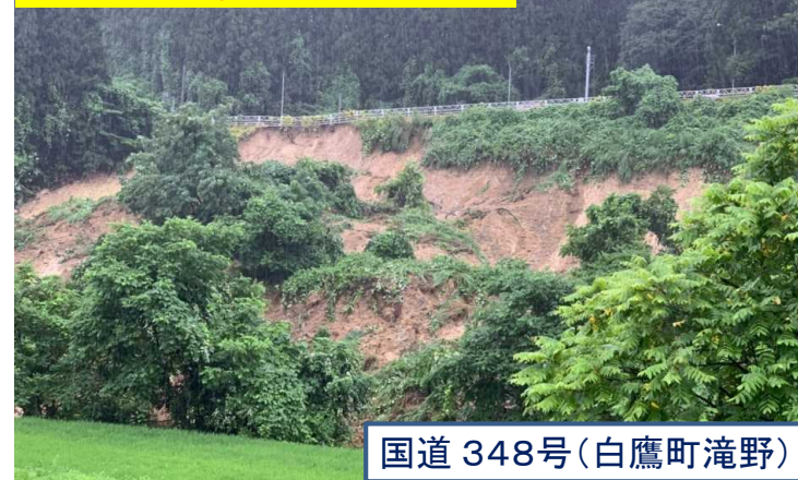
道路法面が約140mに渡り崩落
