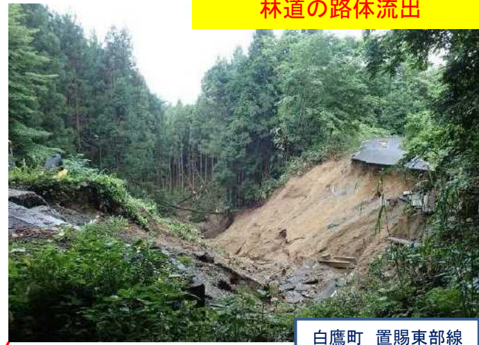
林道の擁壁倒壊
