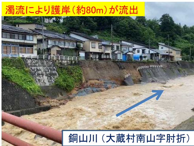
発電施設付近で地すべりが発生
