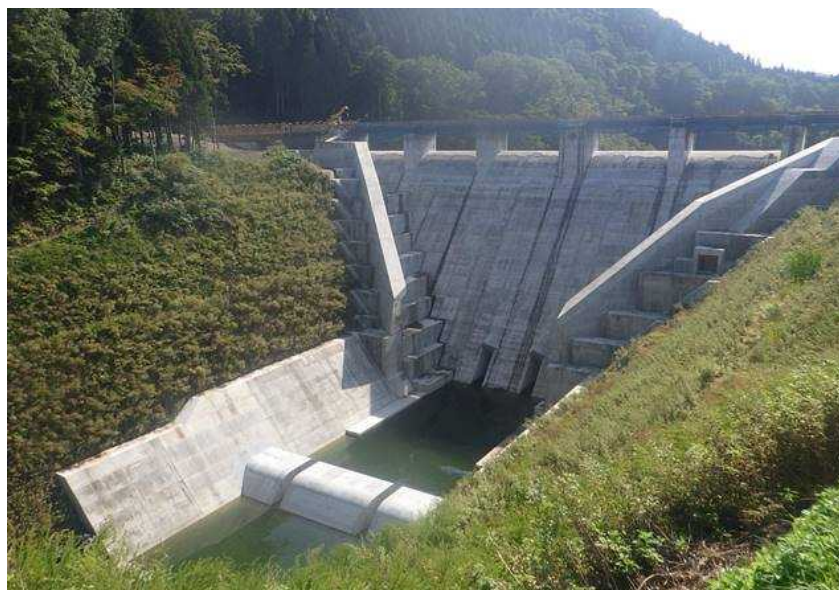
堤体整備状況(下流より)
