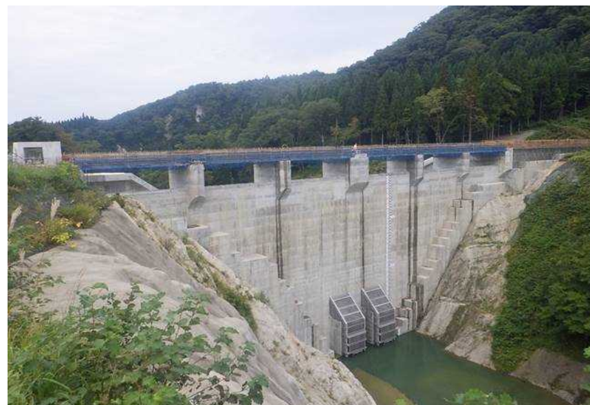
堤体整備状況(上流より)
