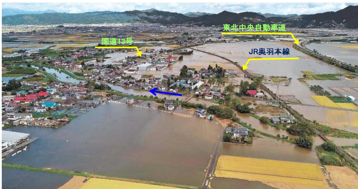
和田川周辺浸水状況 (高畠町夏茂周辺)
