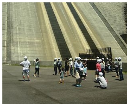
長井ダム見学
