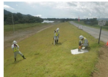
定期横断測量状況
