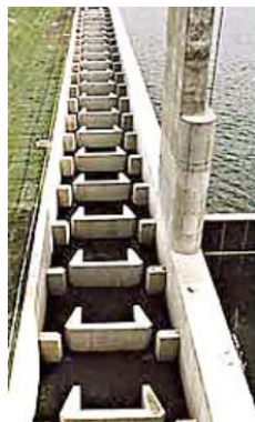
下流側から見た魚道
