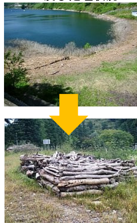
白川ダム流木撤去前及び処理状況
