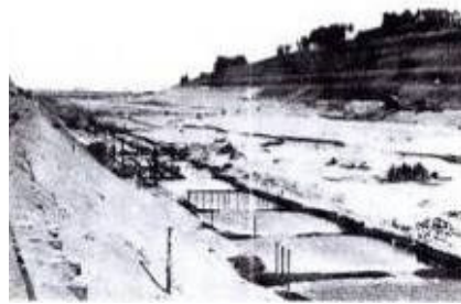
放水路開削工事の様子（昭和 8 年）
