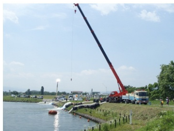
内水排除訓練
