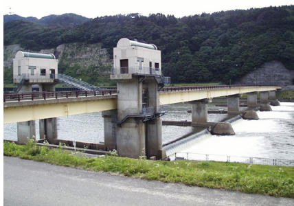
最上川さみだれ大堰
