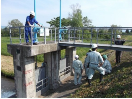
樋門樋管点検
