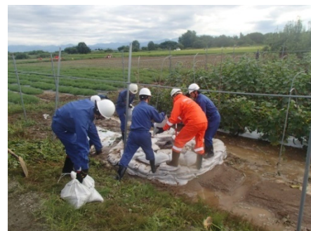
漏水による水防活動状況 （釜段工法）
