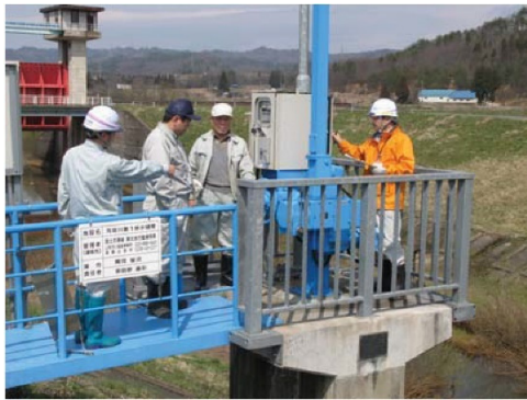
施設点検（樋門ゲート設備）の状況
