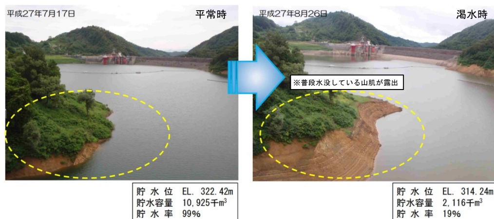
白川ダム貯水状況
