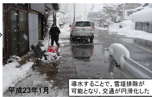
整備後（大蔵村清水）
