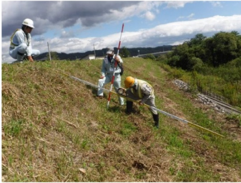
除草後の堤防点検
