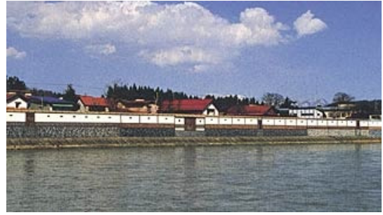
大石田特殊堤修景
