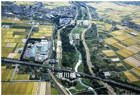
須川鉄道橋付近の樹木状況
