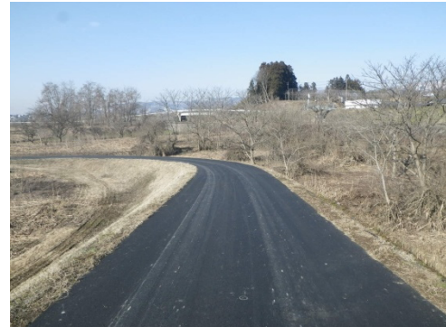
堤防の天端舗装補修後の状況
