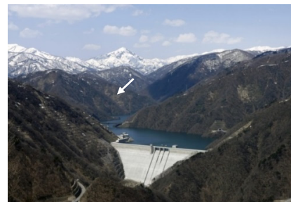
長井ダム (平成 23 年完成)
