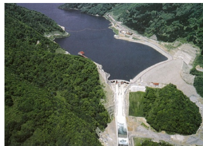
寒河江ダム (平成 3 年完成)
