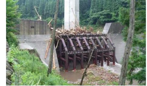
透過型砂防堰堤 (熊本県小国町)
