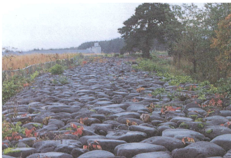
写真3 直江石堤 (米沢市赤崩地区)
