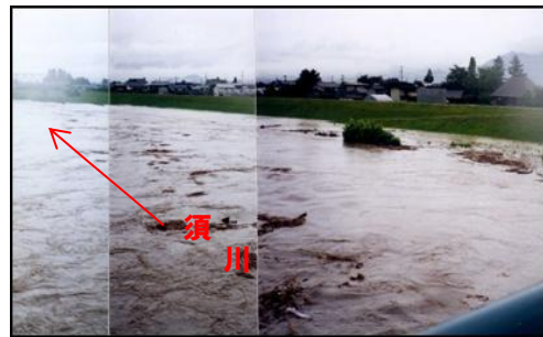
平成14年7月洪水出水状況 (山形市中野目地区)
