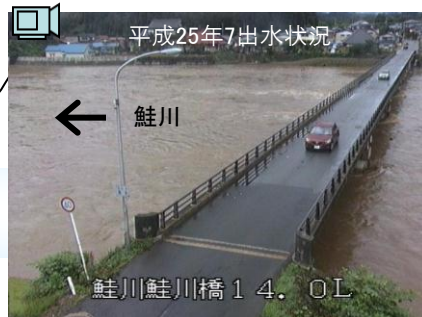
(鮭川橋右岸から対岸方向)
