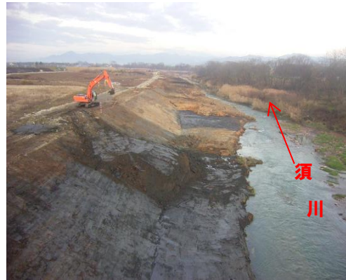
河道掘削状況 (山形市中野目地区)
