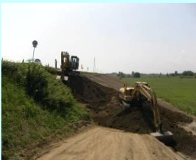
堤防拡幅状況 (河北町大富地区)
