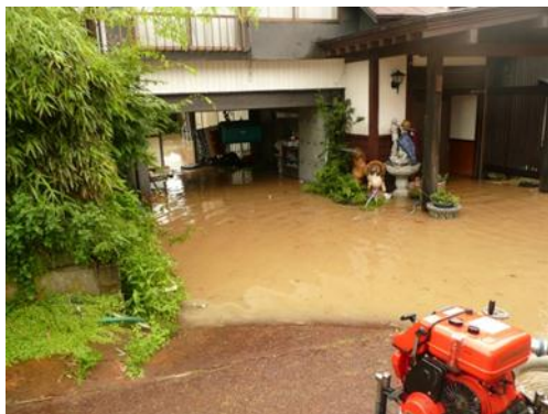
最上川の増水による家屋浸水状況（新庄市畑地区）
