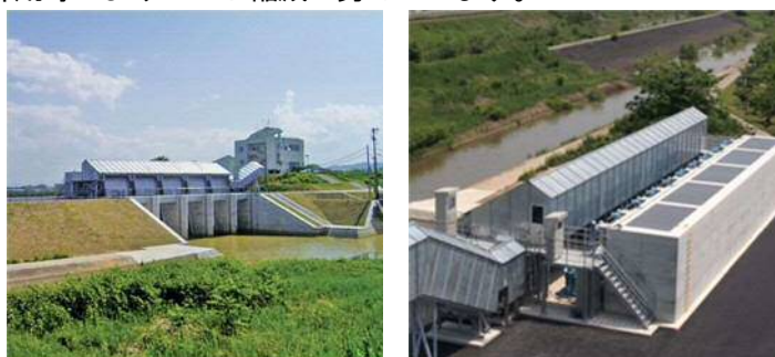
改築後（平成 26 年 6 月完成）の大旦川排水機場
