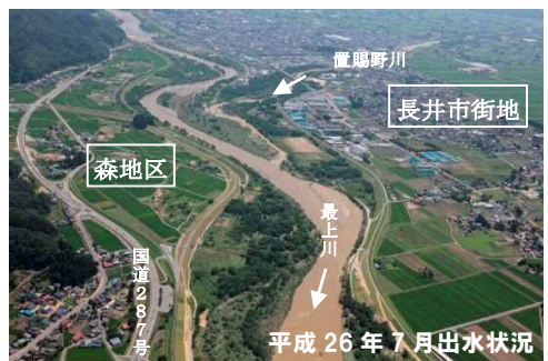
上流部改修事業（右岸：森地区）
