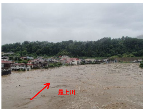
最上川の増水による家屋浸水状況（大江町百目木地区）
