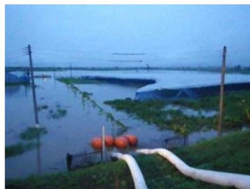
最上川の増水による内水状況（川西町西大塚地区）
