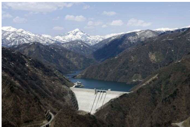
長井ダム（平成 23 年完成）
