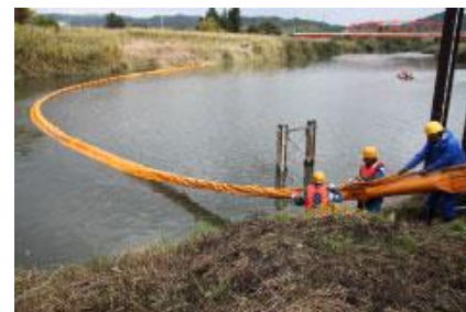
水質事故の迅速な対応のための オイルフェンス設置訓練状況
