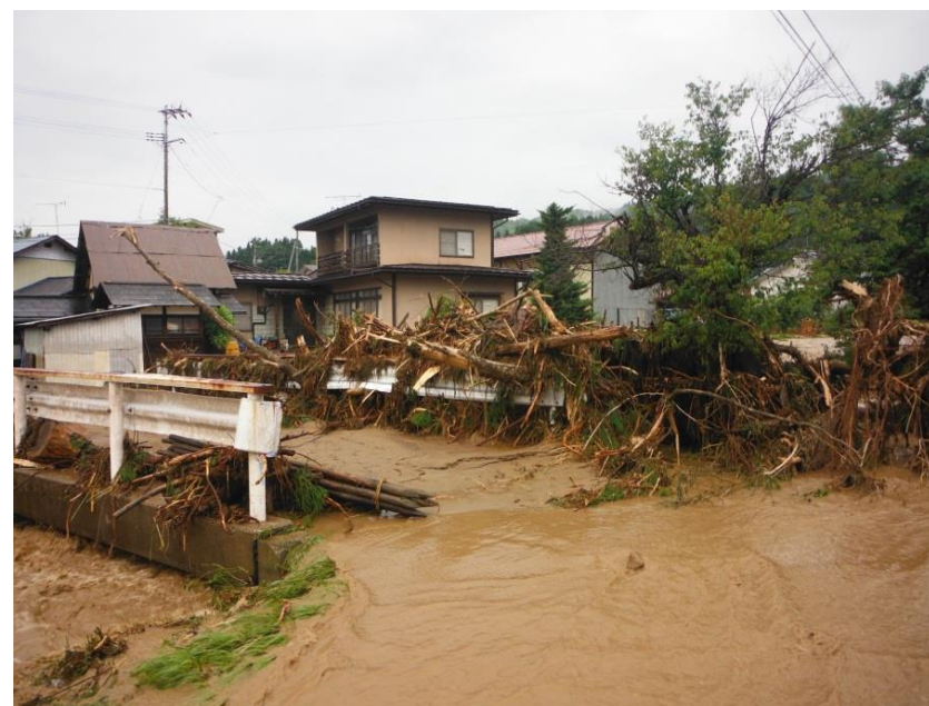
川原橋付近の状況
