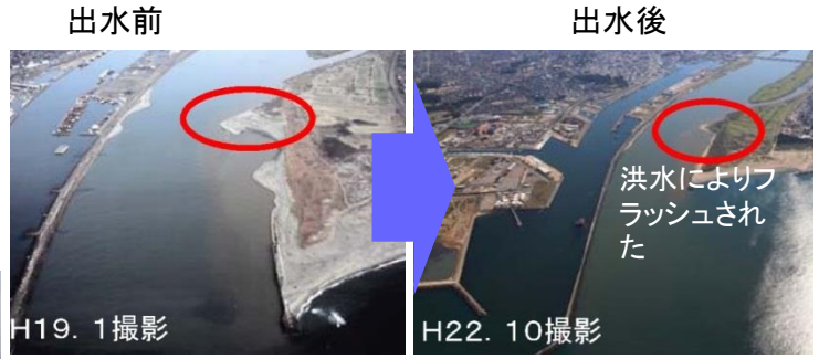
斜め写真による河道状況の把握 （平成19年9月洪水による河口砂州形状の変化の様子）
