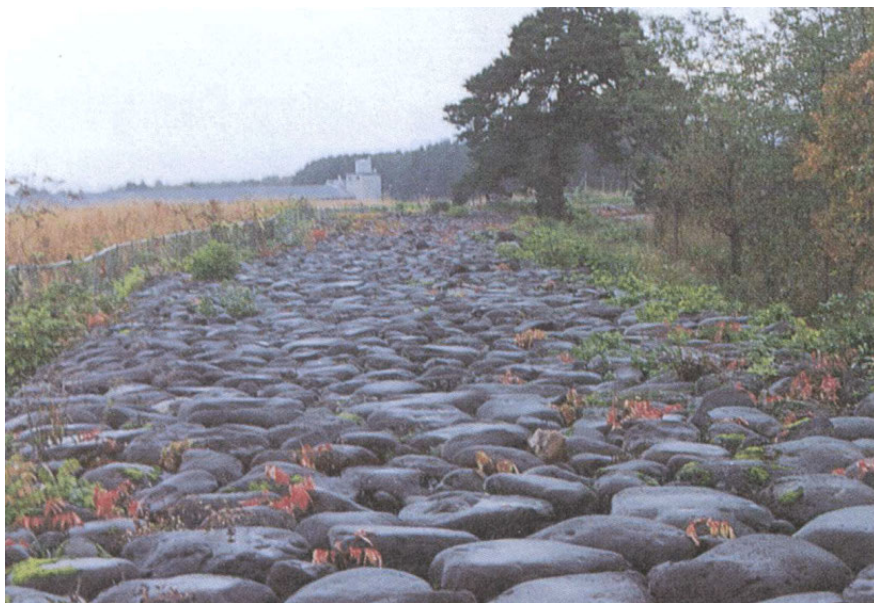
写真3 直江石堤（米沢市赤崩地区）
