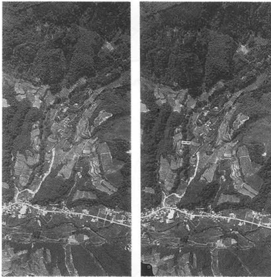
図2 猿山沢・ドウワイ沢の立体写真 上が西、手前左が幸生集落。一は砂防ダム計画地点
