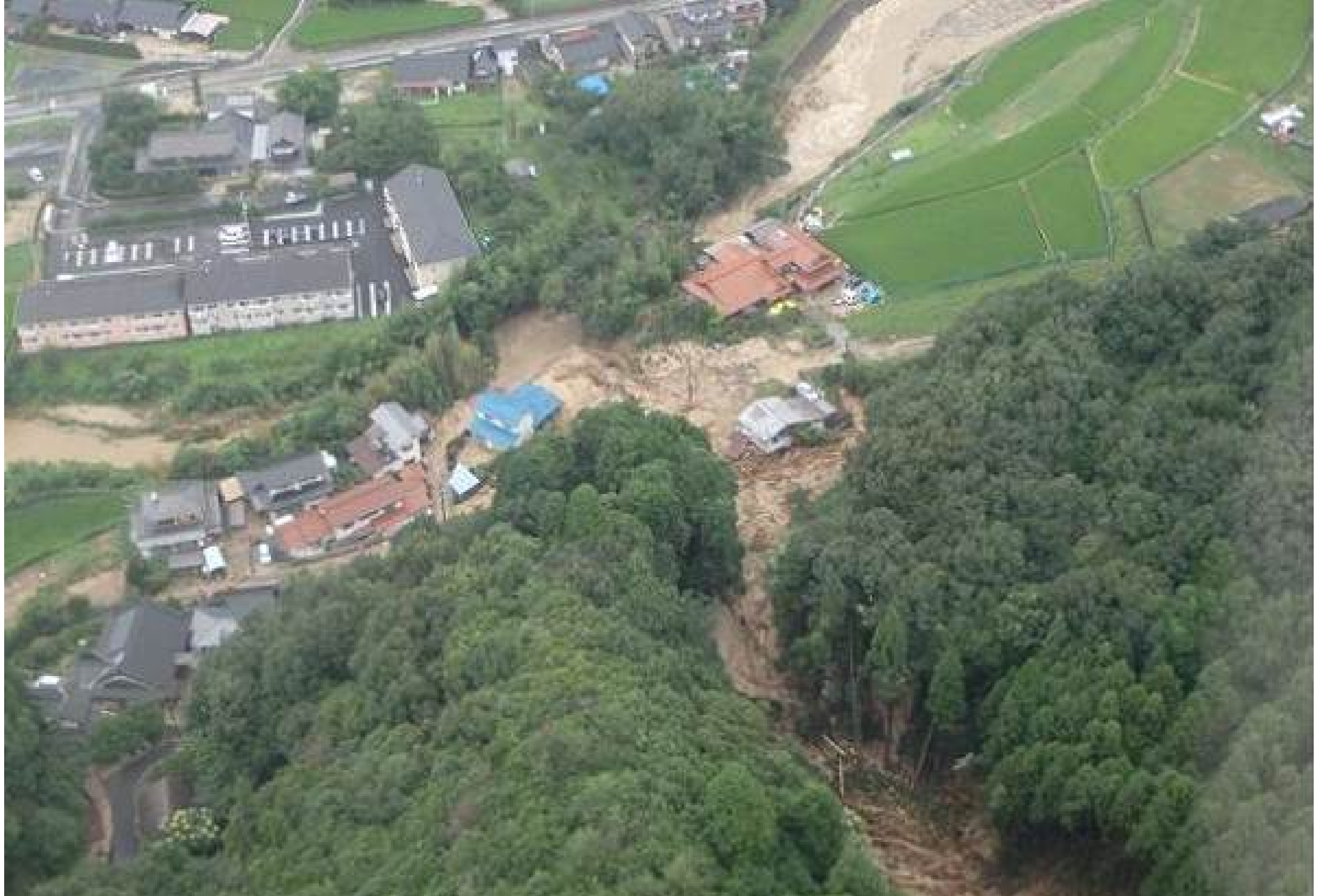
平成26年8月に広島県で発生した土砂災害
