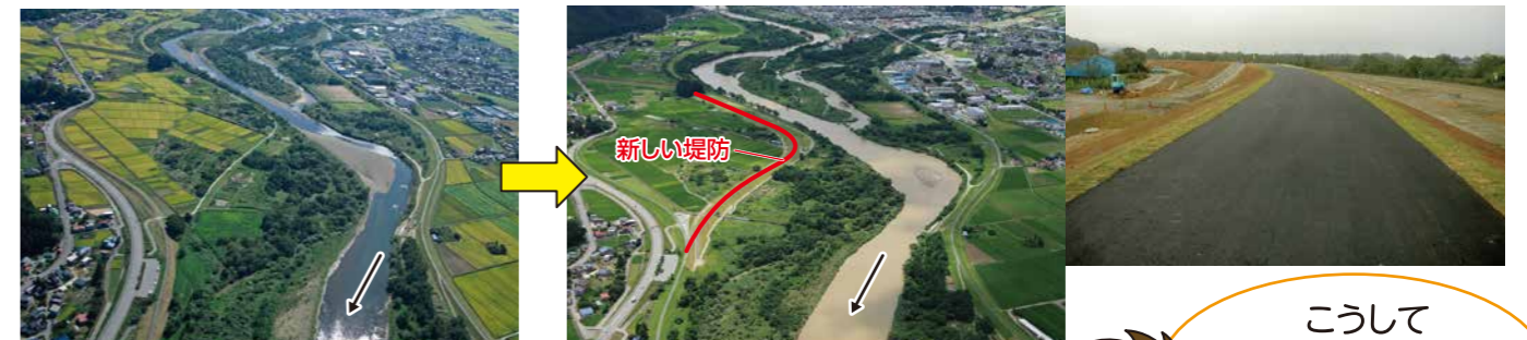
最上川の堤防工事前 (長井市五十川)
