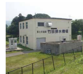
竹田排水機場 (酒田市)
