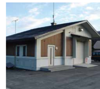
古口排水機場 (戸沢村)
