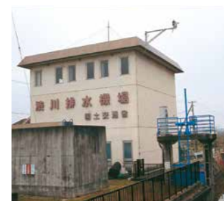
渋川排水機場 (東根市)
