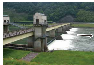
2 最上川さみだれ大堰
