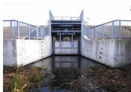
歌丸第一排水樋門
