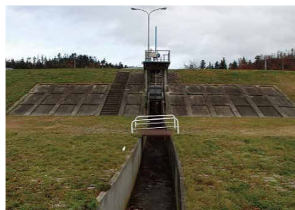
河島排水樋管
