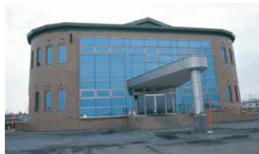
5 河川防災ステーション
