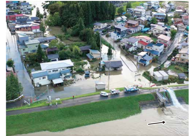
最上川・排水作業 (高島町糠野目)
