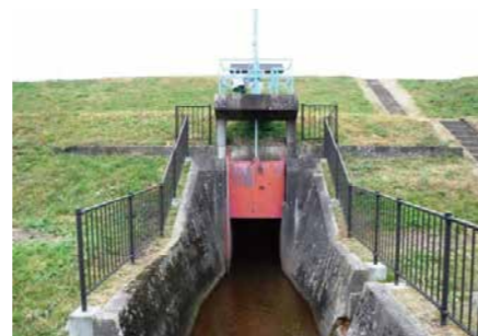
菖蒲排水樋管
