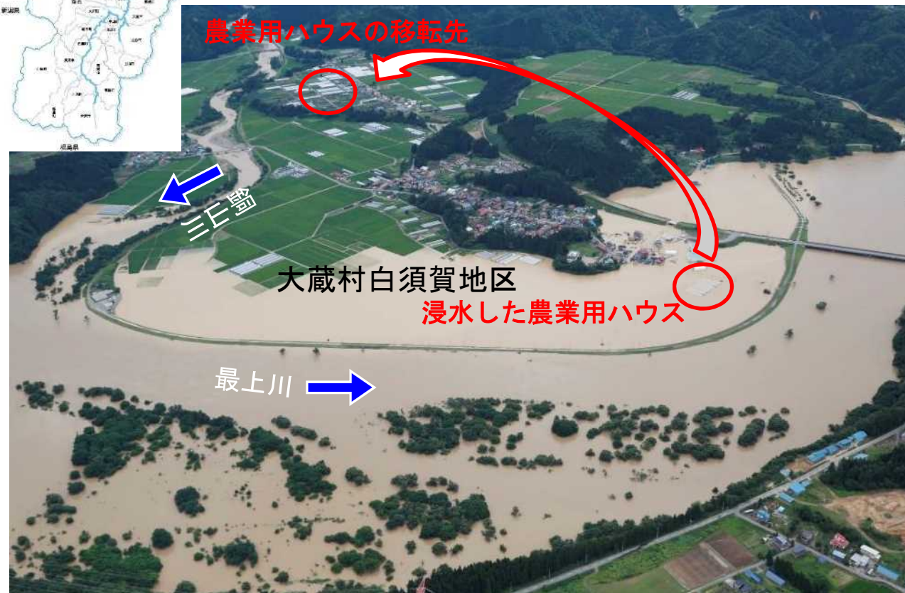
令和2年7月洪水により浸水した大蔵村白須賀地区
