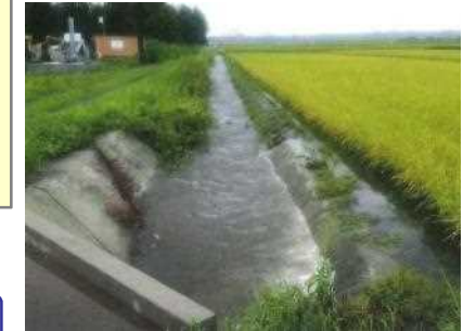
平成30年8月の大雨時の排水路の状況
