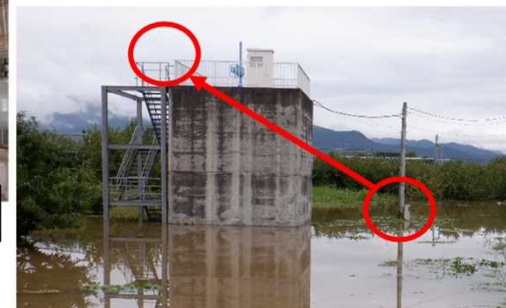
浸水のおそれのある受電盤の移設
