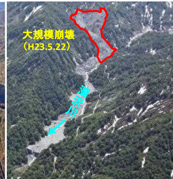
〔濁沢川で発生した大規模崩壊(H23.5)〕
