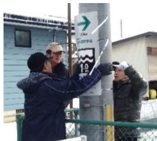
電柱などに浸水の深さ、避難ルートの案内看板を設置
