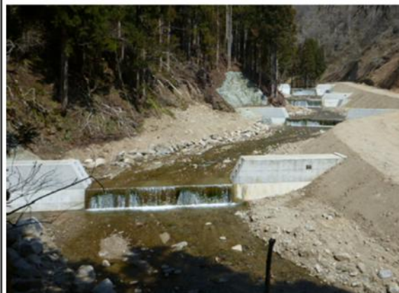
渓床の安定化を図る治山ダム
