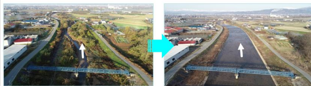
▲ 村山野川(東根市) 令和元年度実施 支障木伐採・堆積土砂撤去
