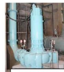
設備機械の防水化 (耐水型モーター)
