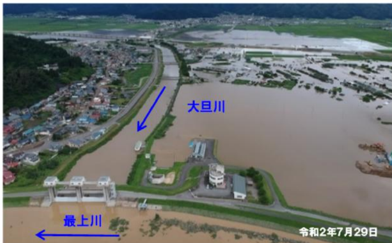
被害状況(浸水被害)
