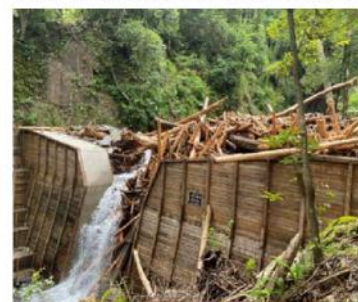
流木捕捉式治山ダムが流木を捕捉した事例【熊本県球磨村】
