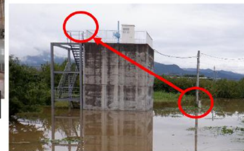
浸水のおそれのある受電盤の移設
