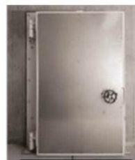
防水扉の設置
