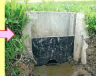
水戸板設置状況
