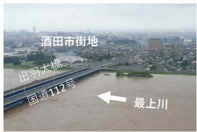
【国】最上川3.0km付近(出水の状況)
