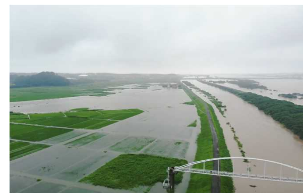
《最上川5.0k付近の浸水被害状況》
