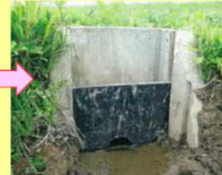
水戸板設置状況
