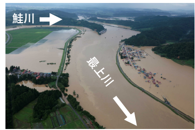
【国】最上川44.3k付近(出水の状況)
