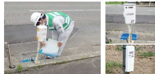
川西町で設置されたワンコイン浸水センサ
