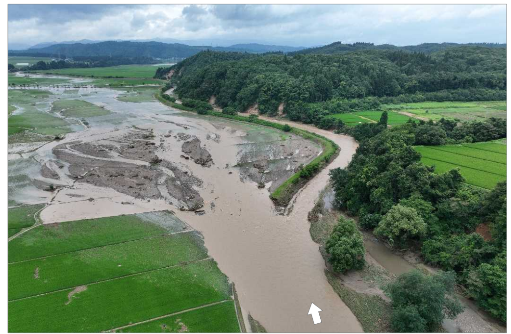
新田川（新庄市本合海）破堤による浸水
