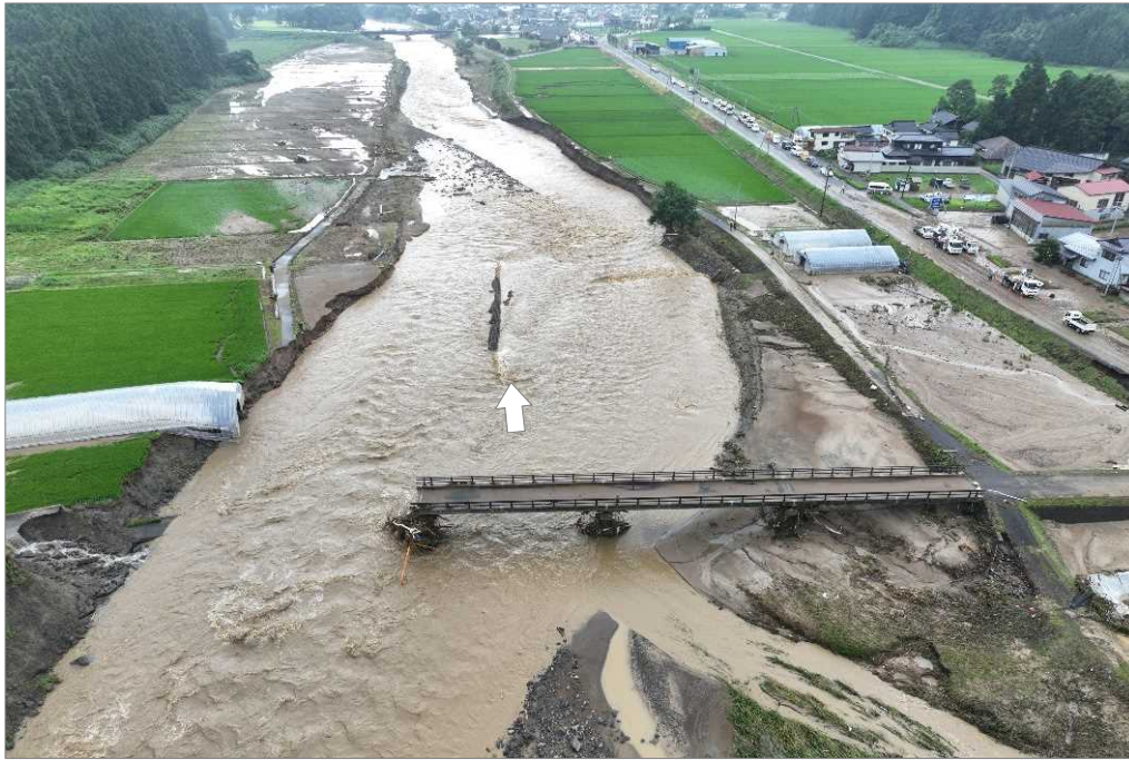
荒瀬川（酒田市常禅寺ほか）溢水による浸水
