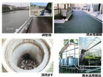
雨水貯留浸透施設の例
