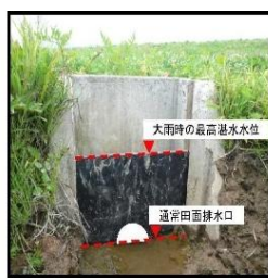
水位調整板の設置状況
