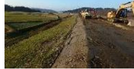
堤防整備（大蔵村白須賀地区）
