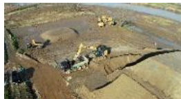
河道掘削（河北町谷地地区）
