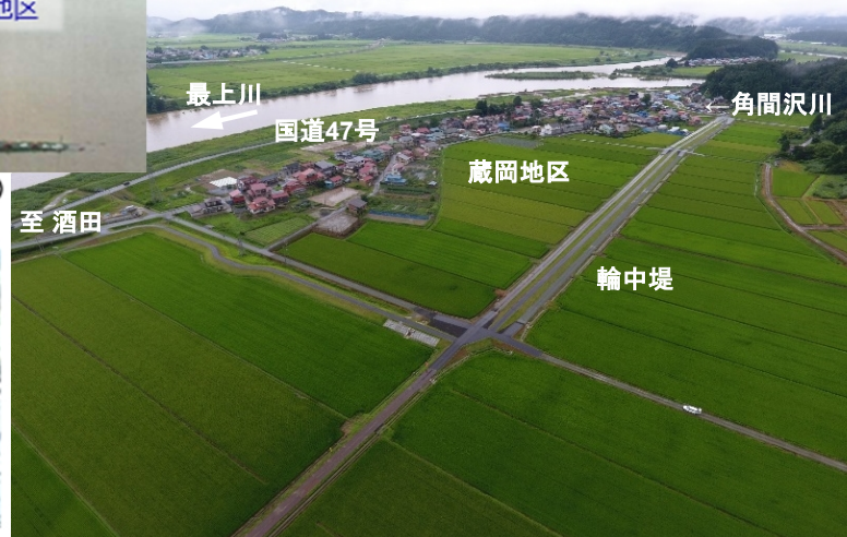
輪中堤整備状況 (R4.7月)
