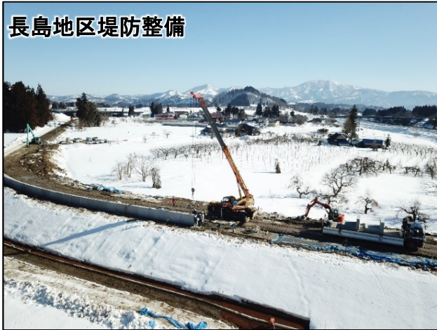
特殊堤施工状況
