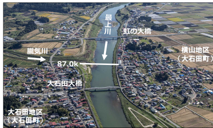
着手前状況 (横山・大石田地区)
