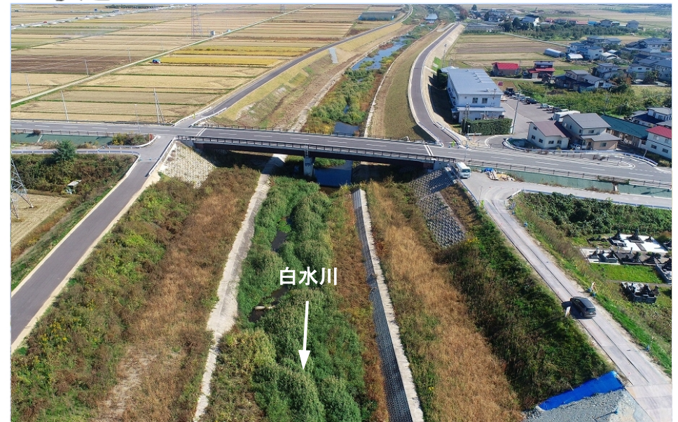
施工状況 (R4.10月)
