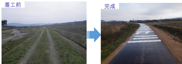
堤防強靱化実施状況(升形川[新庄市])
