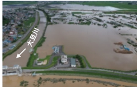
被災状況(R2.7月)
