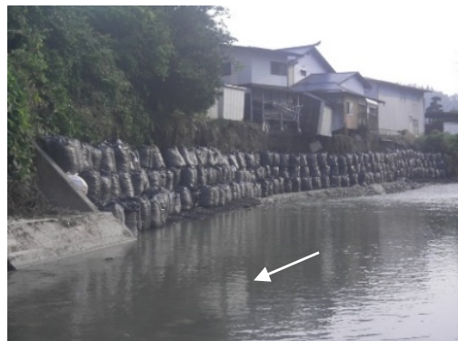
応急工事後(R3.8.6)
