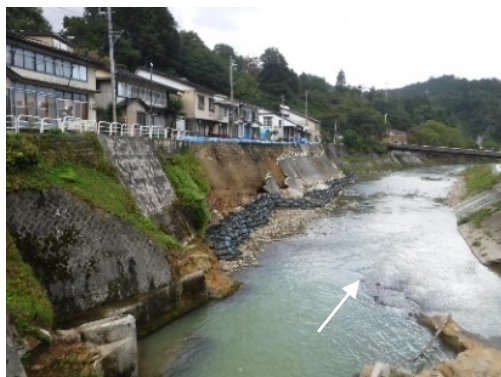
応急工事後(R2.10.6)
