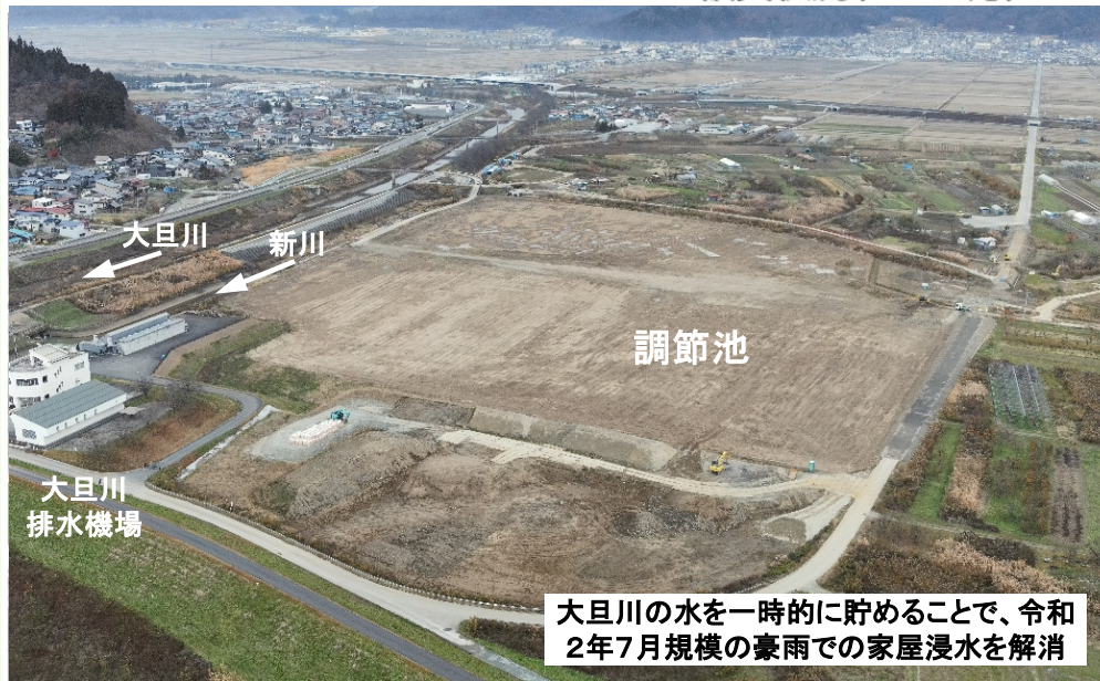
施工状況 (R4.11月)
