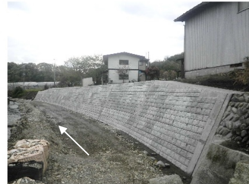
工事完了(R3.5.1)
