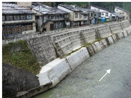
工事完了(R3.9.1)
