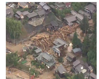
土石流等(新潟県 村上市)
