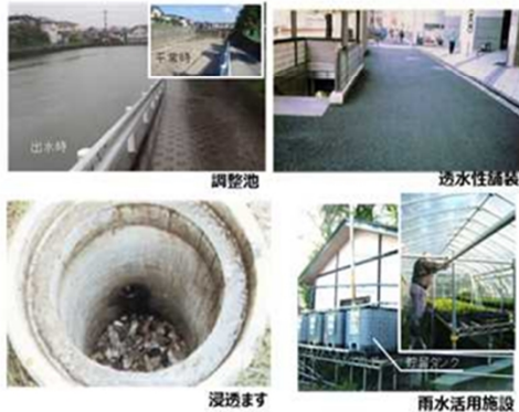
雨水貯留浸透施設の例
