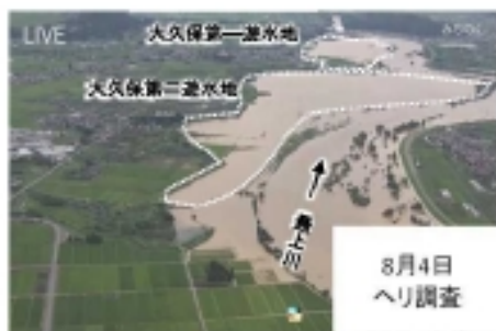
【遊水地への湛水状況(令和4年8月4日)】
