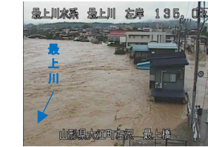
最上川水系最上川の溢水による氾濫状況(山形県 大江町)
