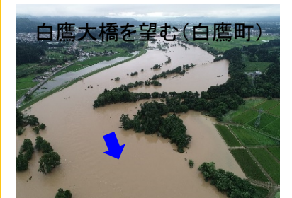
荒砥狭窄部上流の状況
