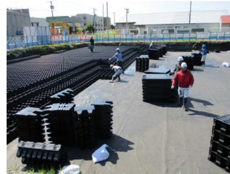
貯留材の設置状況
