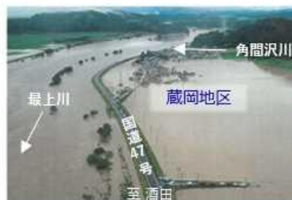
↑被災状況(H30.8月)
