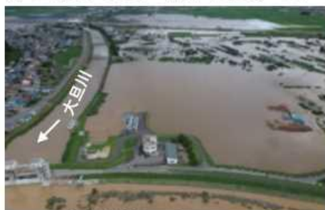
被災状況(R2.7月)
