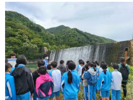
六湊砂防堰堤
