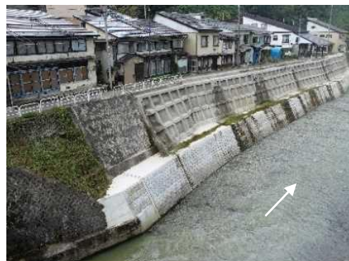
工事完了(R3.9.1)
