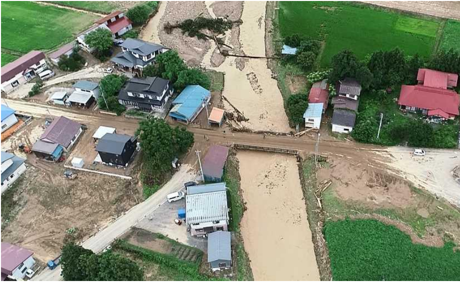
飯豊町萩生地区における浸水被害
