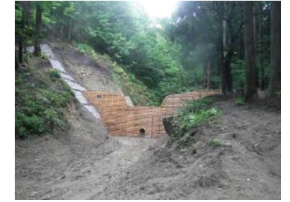
【治山：溪間工(治山ダム)】
