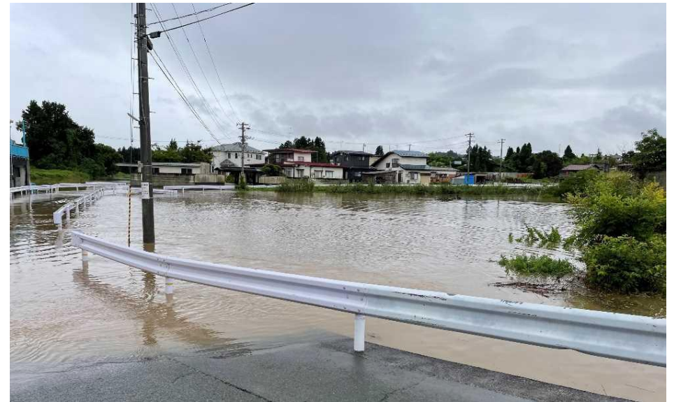
大江町左沢地区における内水被害
