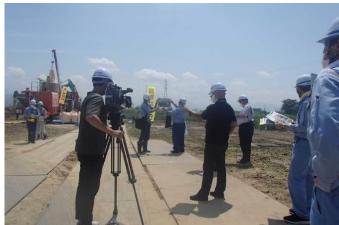
最上川河道掘削工事の説明
