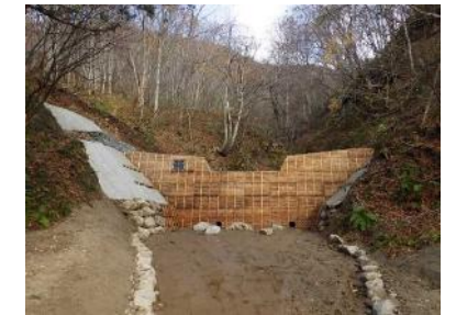
【治山：渓間工（治山ダム）】
