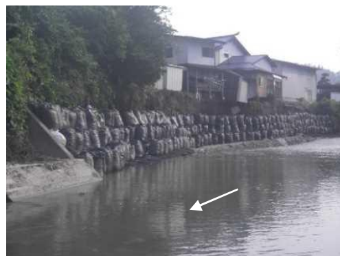
応急工事後(R2.8.6)
