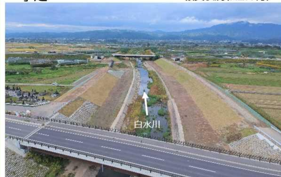
施工状況(R3.10月)
