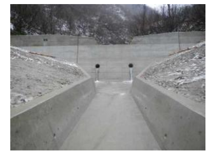
【治山：渓間工(治山ダム)】
