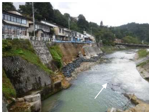
応急工事後(R2.10.6)
