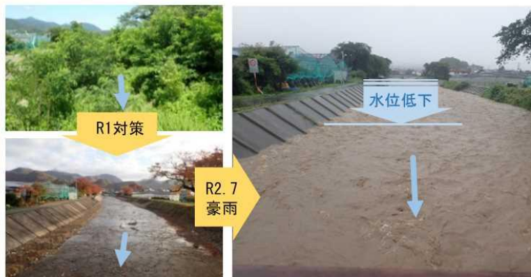
取組み事例(堆積土砂の浚渫・支障木の伐採)
