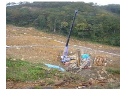
【治山：地すべり防止工】
