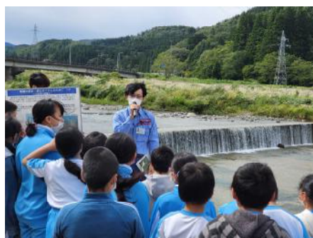
立谷沢川流路工
