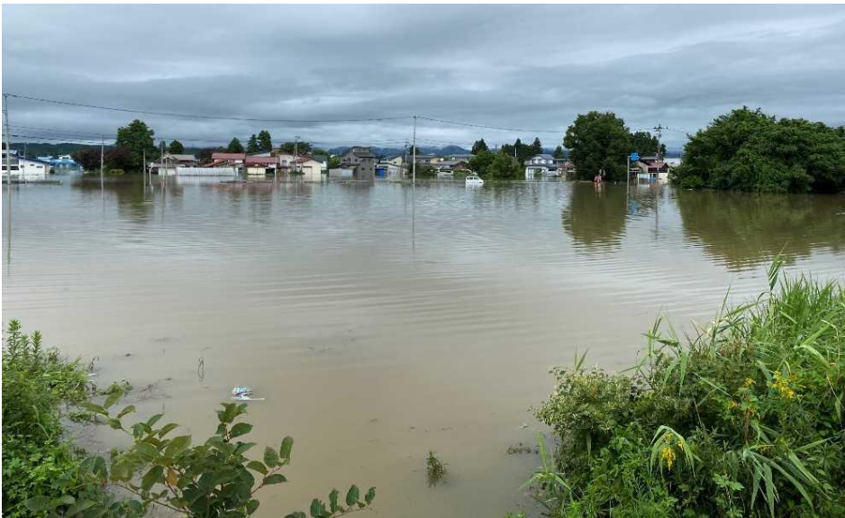
川西町黒川地区における内水被害
