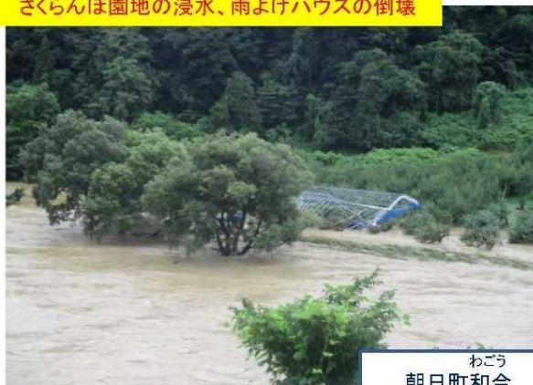
さくらんぼ園地の浸水、雨よけハウスの倒壊
