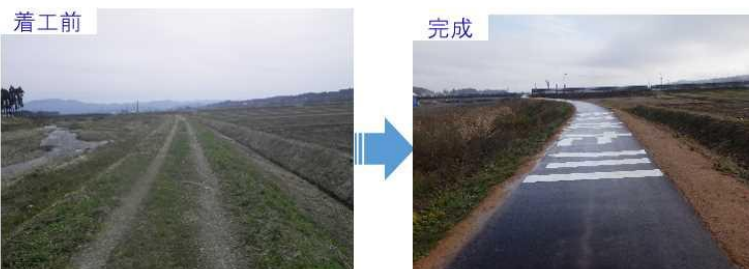
堤防強靱化実施状況(升形川[新庄市])
