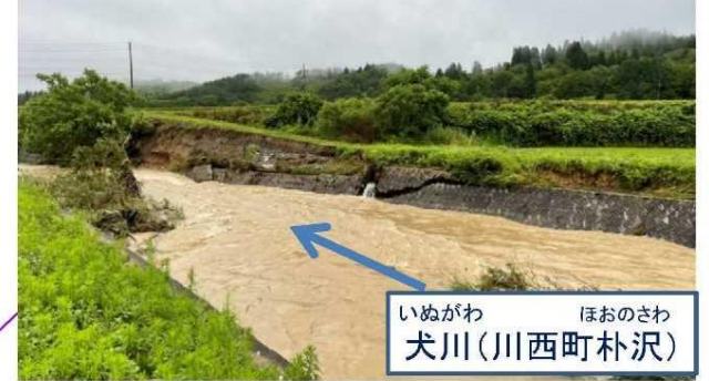
護岸損壊(150m)
