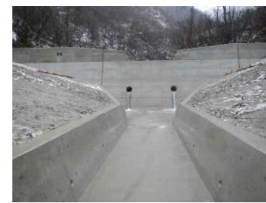
【治山：渓間工（治山ダム）】
