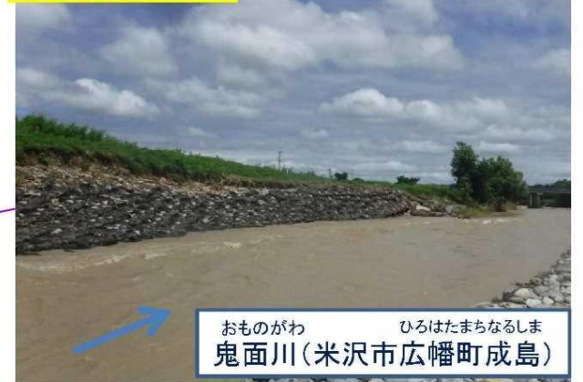
護岸損壊(150m)
