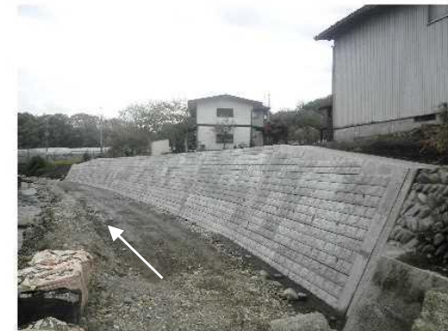
工事完了(R3.5.1)
