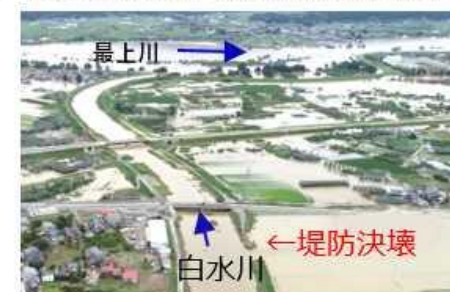
被災状況(R2.7月)
