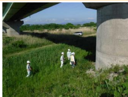
▲最上川白鳥大橋点検(東日本高速道路(株)と合同)
