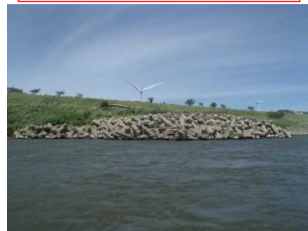
船上から見た河川管理施設(水制工)
