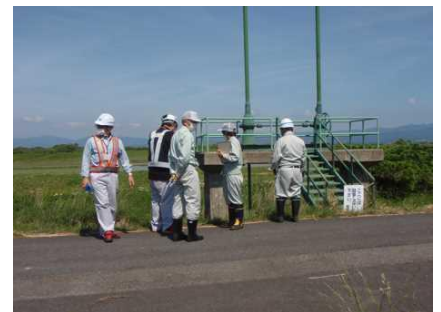
▲道形排水樋門(鶴岡市土木課と合同)
