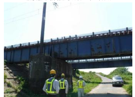
▲最上川第二橋梁点検(JR東日本と合同)
