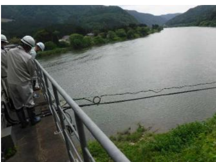
▲最上川取水口（最上川土地改良区と合同）
