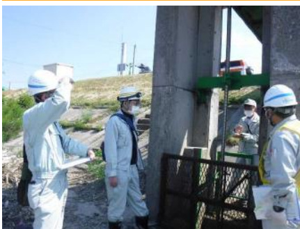
▲下瀬樋管点検(庄内総合支庁と合同)
