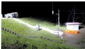
排水ポンプ車による内水排除状況
