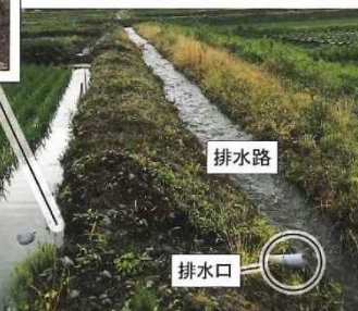
堰板による止水状況
