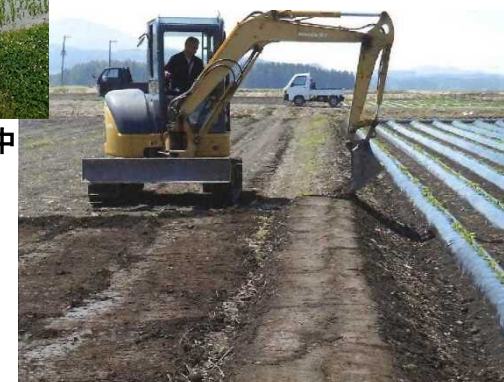
バックホウによる畦畔の嵩上げ
