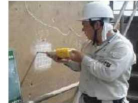
老朽化した施設の機能診断
