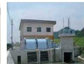
排水機場の整備
