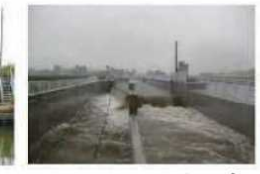
(排水分水ゲート)
