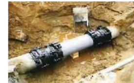
漏水防止のための整備
