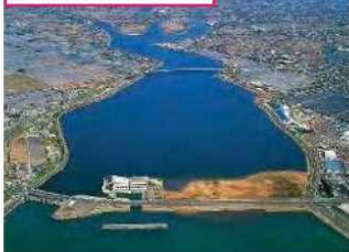
排水機場と周辺の市街地
