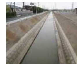
排水路の整備
