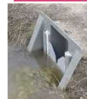
堰板等を設置し、雨水を水田に一時的に貯留
