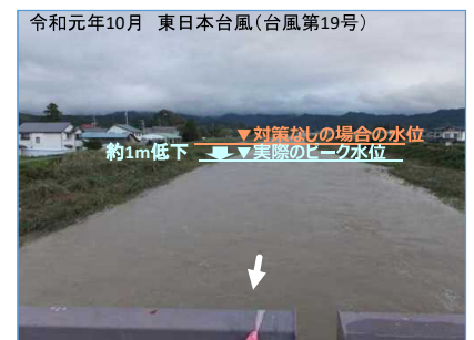
▲ 屋代川(高島町)平成30年度実施 堆積土砂撤去 堆積土砂の撤去により水位が約1m低下と推定 氾濫危険水位を上回ることなく浸水被害軽減に効果を発揮
