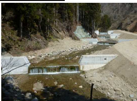
渓床の安定化を図る治山ダム
