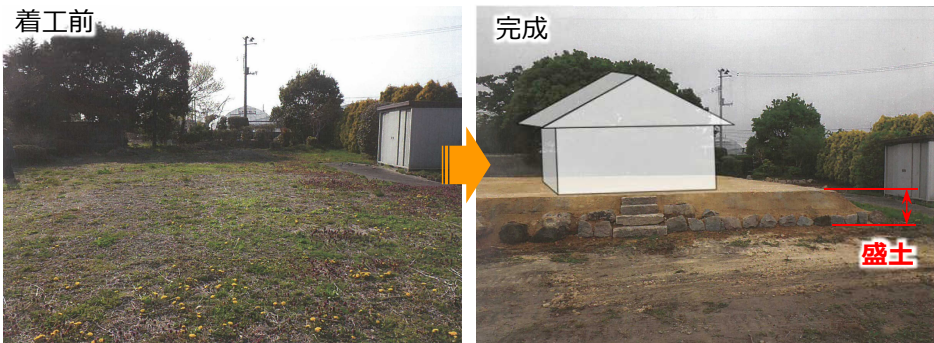
【大崎市内で実施された盛土工事の事例】
