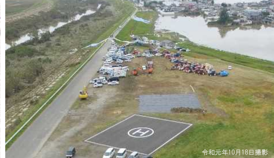
令和元年台風19号での水防災拠点への避難状況 宮城県大崎市(吉田川)
