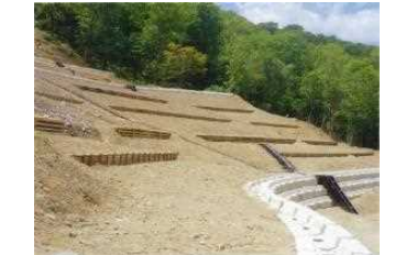
【治山：山腹工(雫石町)】
