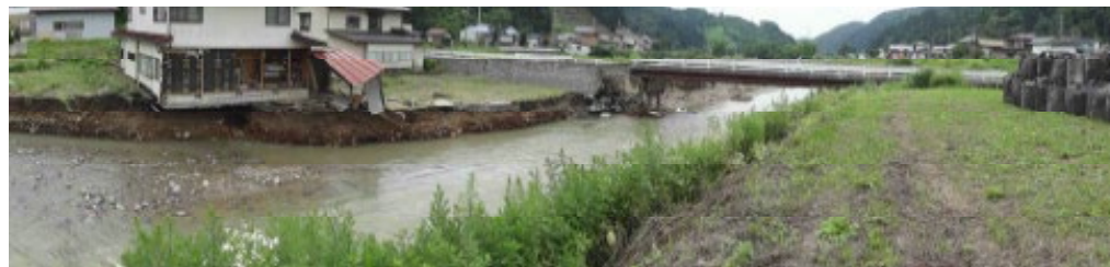
平成25年7月豪雨吉野川金山地区 土木学会報告書
