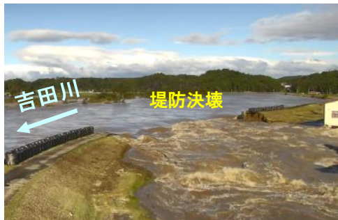
▲吉田川の堤防決壊箇所(R1.10月:宮城県大郷町)
