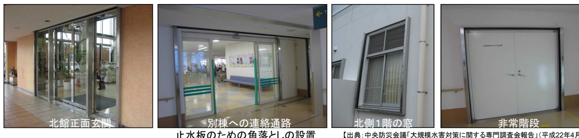
止水板のための角落との設置
