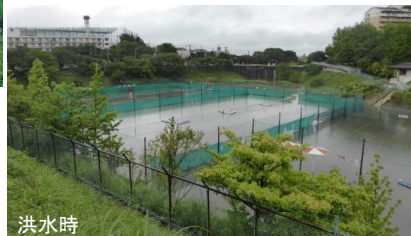
【事例：霧が丘調整池(横浜市)】
