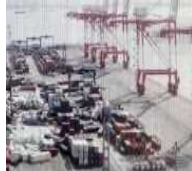
⑥神戸港六甲アイランドにおける浸水被害 (兵庫県神戸市)
