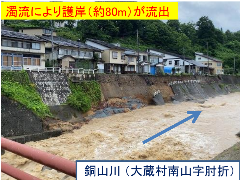
発電施設付近で地すべりが発生
