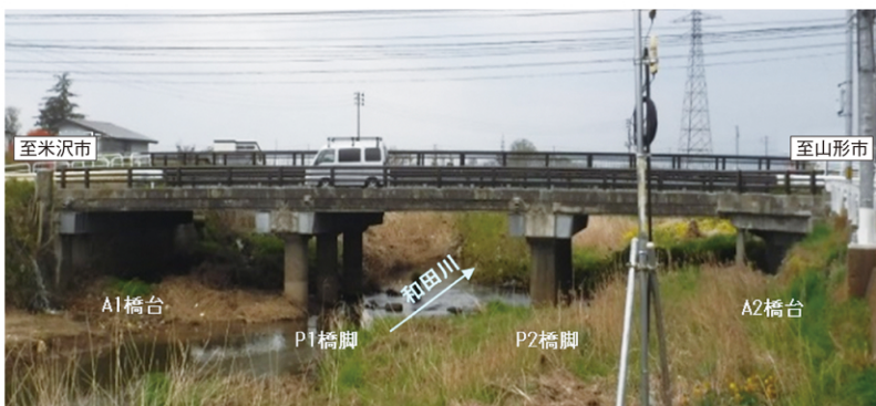
津久茂橋 橋梁全景
