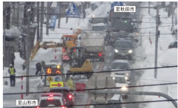
国道13号運搬排雪 * に伴う通行規制 * 道路脇に堆雪した雪を除雪機械で切り崩し、トラックに積み込み運搬除去する作業
