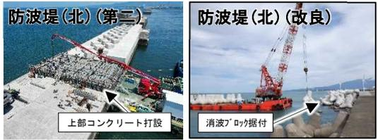
自然災害リスクに対する防災・減災等を図るため、防波堤の上部コンクリート打設及び消波ブロック据付を実施します。
