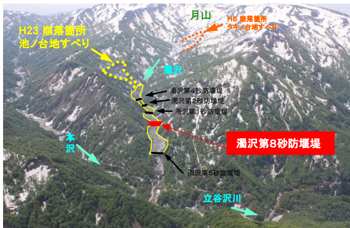
大規模崩壊後の立谷沢川流域濁沢
