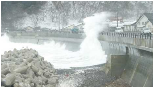
▲国道7号の越波状況
