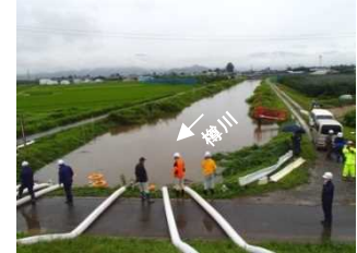
平成26年7月洪水時の状況
