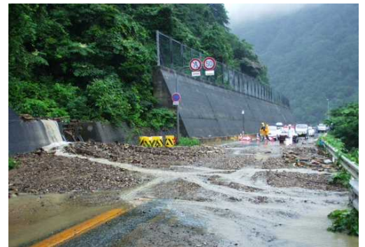
▲国道47号猪ノ鼻地区の被災状況
