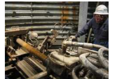
集水ボ-リング 施工状況
