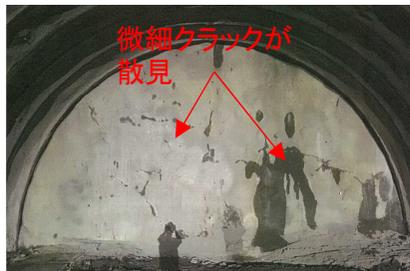
▲2019.1.14 鏡面に地山膨張による微細クラック発生
