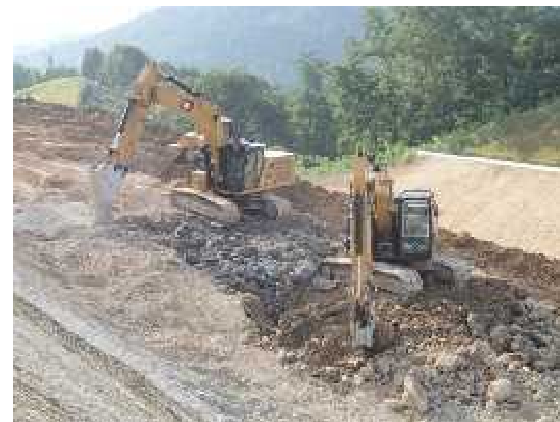
▲軟岩掘削(ブレーカ掘削)
