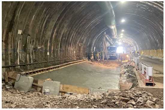
【インバート施工状況】
