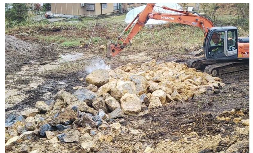
▲転石破碎作業状況
