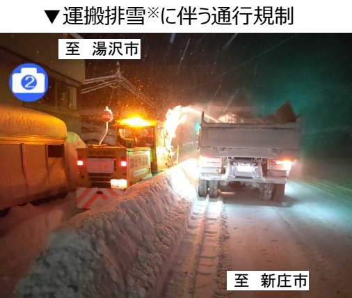
※道路脇に堆雪した雪を除雪機械で切り崩し、トラックに積込み、運搬除去する作業
