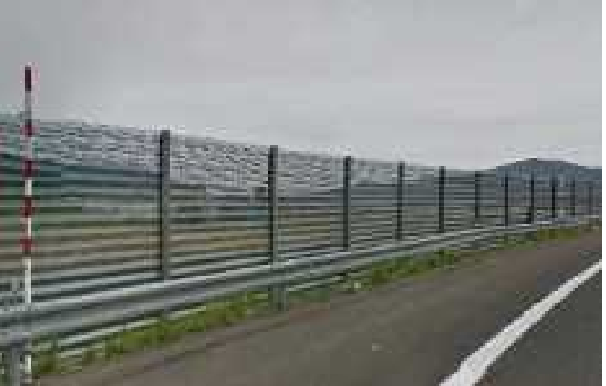
・防雪柵は下り線(北側)に付いており、北西方向からの吹雪に対応している
