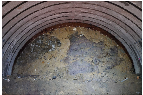
【トンネル掘削断面状況】
