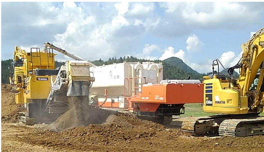
▲土質改良作業状況
