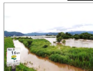
吉野川右岸 1.6km付近 から上流方向
